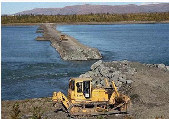
Рис. 45. Строительство защитной дамбы
