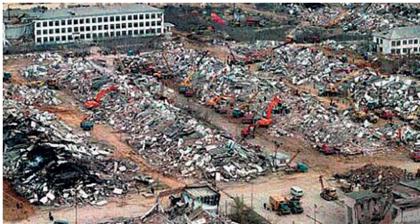
Рис. 53. Последствия землетрясения в Нефтегорске, 1995 г.
