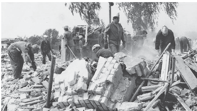
Рис. 33. Работа по устранению последствий взрыва товарного поезда, г. Арзамас
