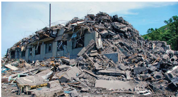
Рис. 21. Последствия землетрясения в Невельске (Сахалин), август 2007 г.
